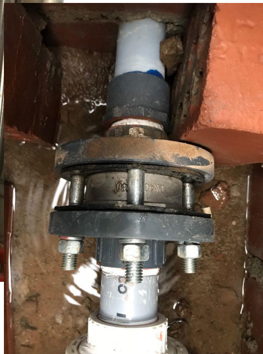
Válvulas check de la electrobomba y de la Línea de Impulsión
