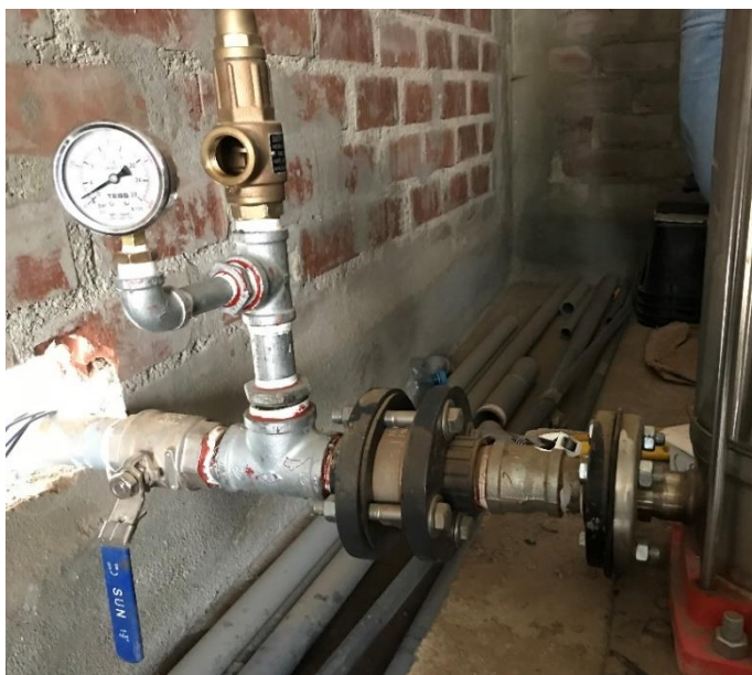
Válvulas check de la electrobomba y de la Línea de Impulsión
