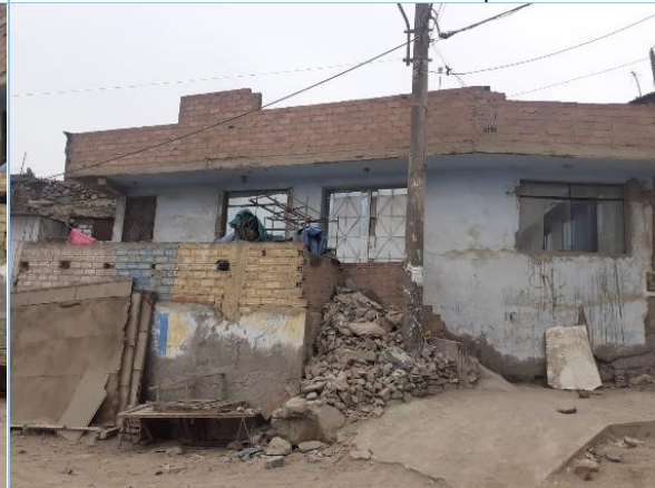
Foto N° 8: Viviendas con estado de conservación regular, presencia de desmonte. Presencia de elemento expuesto de alto riesgo del poste en muy mal estado de conservación.
