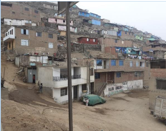
Foto N° 1: viviendas construidas sin seguir normas técnicas.
