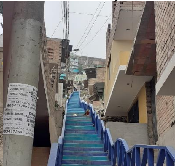
Foto N°4: Mz G, Viviendas y escaleras no cumplen con las normas técnicas de construcción.
