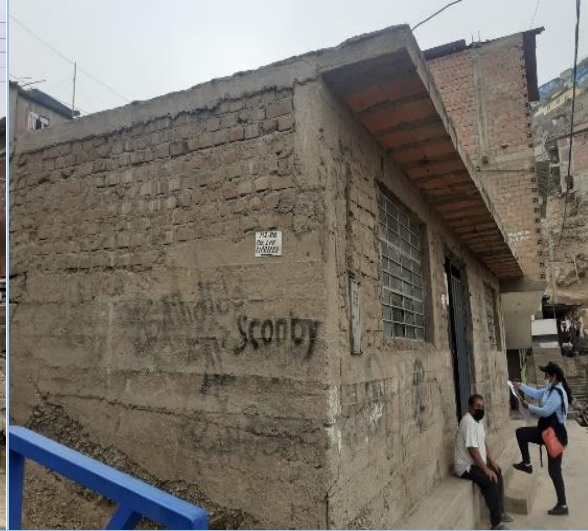
Foto N° 6: Local comunal, infraestructura regular. Presidente del AA.HH. brindando datos del local a promotora.
