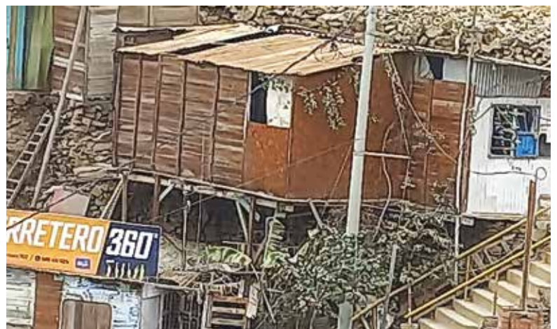
Vivienda liviana "tipo palafito" con estructura de madera que la soporta insuficiente para su peso. Su colapso afectará a otras viviendas vecinas.
