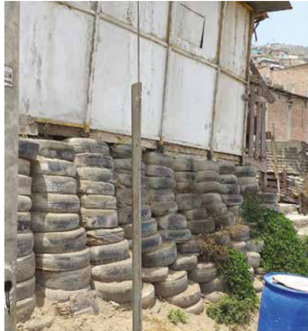
Viviendas livianas sobre la base del apilado de neumáticos, simplemente apoyados en el terreno. No se comportan como una unidad ante sismos.
