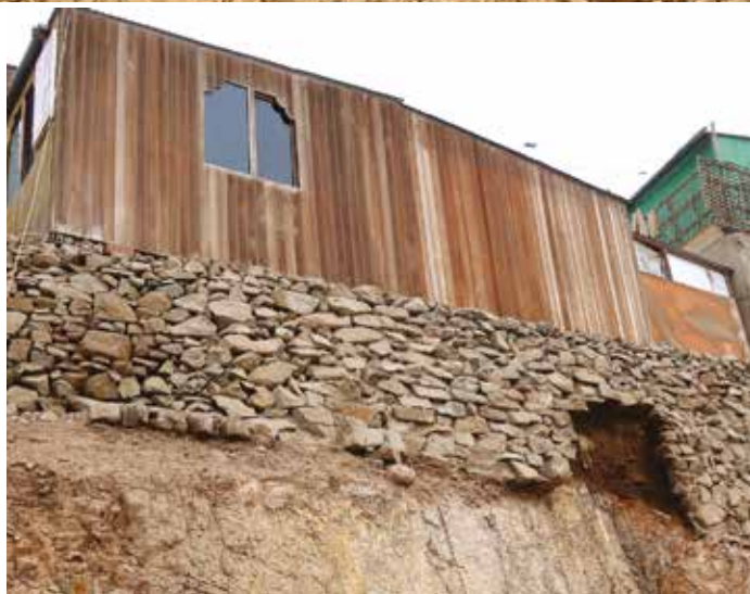
Vivienda liviana "tipo palafito" con estructura de madera que la soporta insuficiente para su peso. Su colapso afectará a otras viviendas vecinas.
