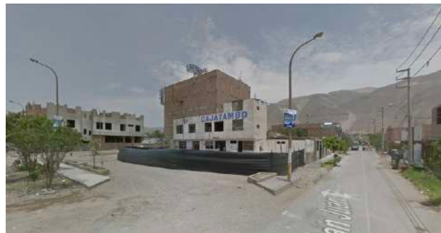
FOTO N.º 15: GRIFO CAJATAMBO, CARRETERA PANAMERICANA NORTE (BASE GOOGLE 2014), NO FUNCIONA.
