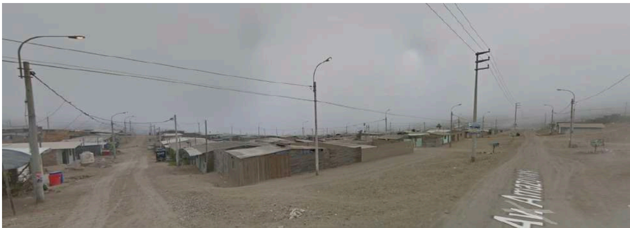
FOTO N.º 11: PROFAM SANTA ROSA. DISTRIBUCIÓN DE LÍNEAS DE MEDIA TENSIÓN DENTRO DE TODO EL TERRITORIO DE SANTA ROSA
