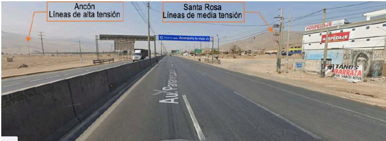
FOTO N.º 10: Av. PANAMERICANA NORTE; LÍNEAS DE TRANSMISIÓN DE 220 KV. L.T. HUACHO-ZAPALLAL (L-2212), LÍNEAS DE TRANSMISIÓN DE 60 KV. L.T. ZAPALLAL-ANCÓN (L-672) (LÍNEAS DE ALTA TENSIÓN QUE PASAN EN EL LÍMITE DE SANTA ROSA Y ANCÓN)
