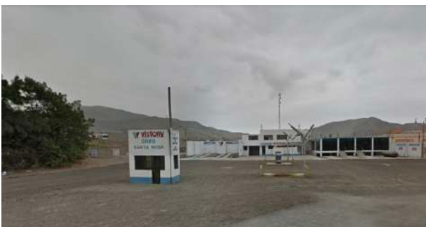
FOTO N.º 16: GRIFO INVERSIONES Y SERVICIOS SAC, CARRETERA PANAMERICANA NORTE (BASE GOOGLE 2014), EN CONSTRUCCIÓN
