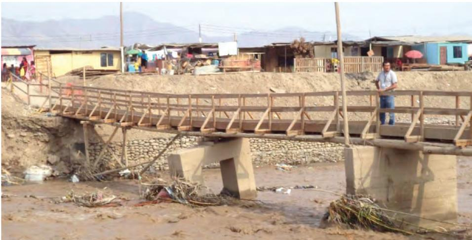
**FOTO N° 03: SIMILAR CARACTERÍSTICAS DE PROBLEMAS ENCONTRADOS EN LAS ZONAS URBANAS VISITADAS. REDUCCIÓN DEL ANCHO DE RÍO POR ACUMULACIÓN DE RELLENOS Y CONSTRUCCIONES SOBRE ESTAS, SIN LAS MÍNIMAS CONDICIONES HIDRÁULICAS. VISTA AGUAS ARRIBA. (CISMID, 2017)**
