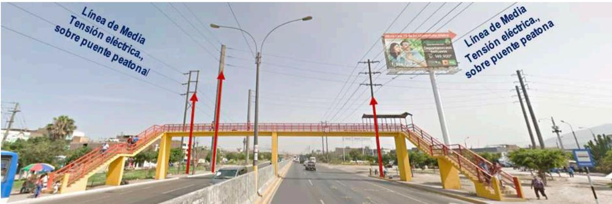
**FOTO N.º 27. Av. PANAMERICANA NORTE, PUENTE PEATONAL CASE, ALTURA CA. PEDRO HELMES, EL CRUCE PEATONAL SE ENCUENTRA CON PROTECCIÓN METÁLICA, ANTE LAS LÍNEAS DE MEDIA TENSIÓN ELÉCTRICA DE 60 KV DE LAS LÍNEAS: LT CHAVARRÍA-PUENTE PIEDRA (L-636), LT CHAVARRÍA-CAUDIVILLA (L-625), LT CHAVARRÍA-NARANJAL (L-698), LT CHAVARRÍA-INFANTAS (L-697).**
