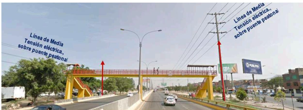
**FOTO N.º 25. Av. PANAMERICANA NORTE, PUENTE PEATONAL VOLVO, ALTURA JR. LAS ACURINAS, EL CRUCE PEATONAL SE ENCUENTRA CON PROTECCIÓN METÁLICA, ANTE LAS LÍNEAS DE MEDIA TENSIÓN ELÉCTRICA DE 60 KV DE LAS LÍNEAS: LT CHAVARRÍA-PUENTE PIEDRA (L-636), LT CHAVARRÍA-CAUDIVILLA (L-625), LT CHAVARRÍA-NARANJAL (L-698), LT CHAVARRÍA-INFANTAS (L-697).**
