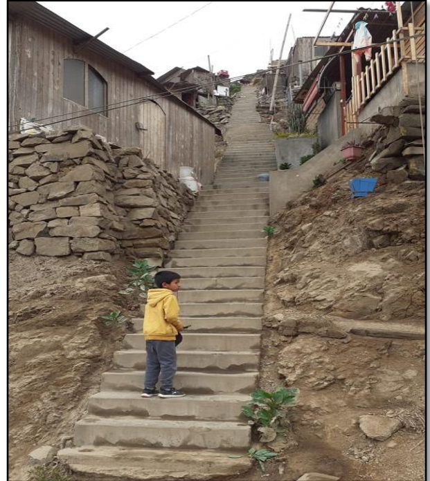
FOTO N°10: Se observa escaleras sin barandas en zona de pendiente mayor a 35°.
