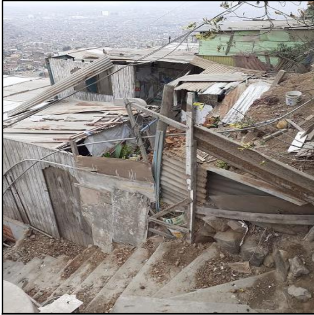
FOTO N°1: Se observa escaleras en pendientes > 35^\circ ante una probabilidad de que ocurriera de sismos de 8.0 a 9.0 Mw, La limpieza de estas vías de acceso es fundamental para el libre tránsito.
